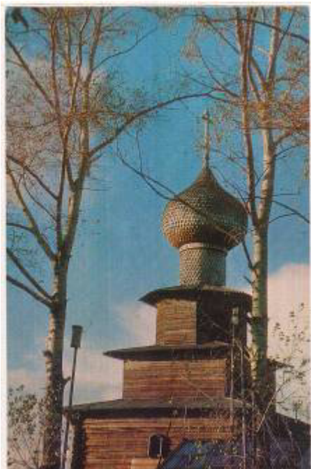
Церковь Ильи Пророка
